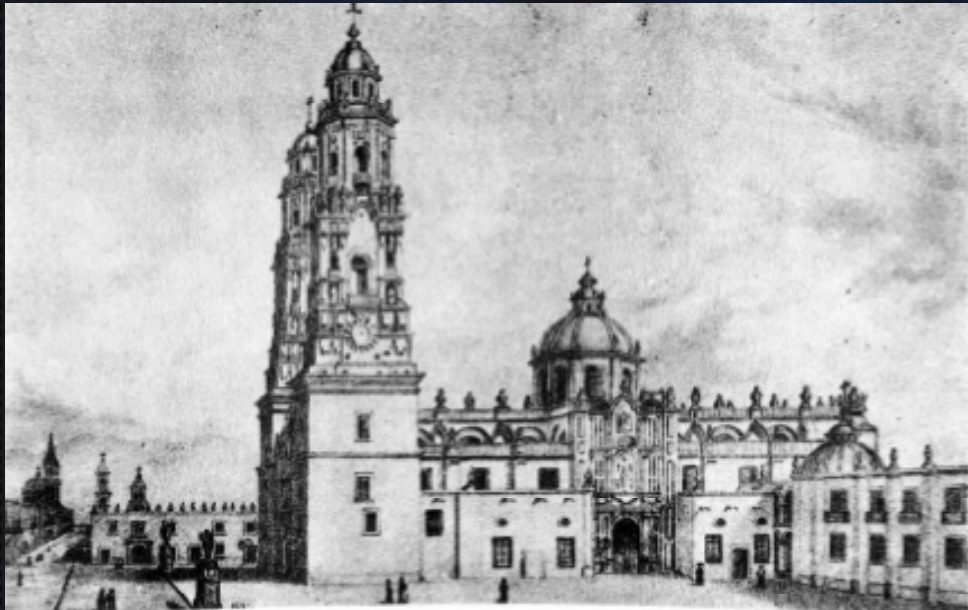
La Catedral de Morelia vista desde su costado poniente. Obsérvese que el atrio hacia la puerta principal es pequeño y no existen las rejas que delimitan el atrio. Esta imagen es una litografía que data del año de 1830 (Tomado de González Galván, 1960).
