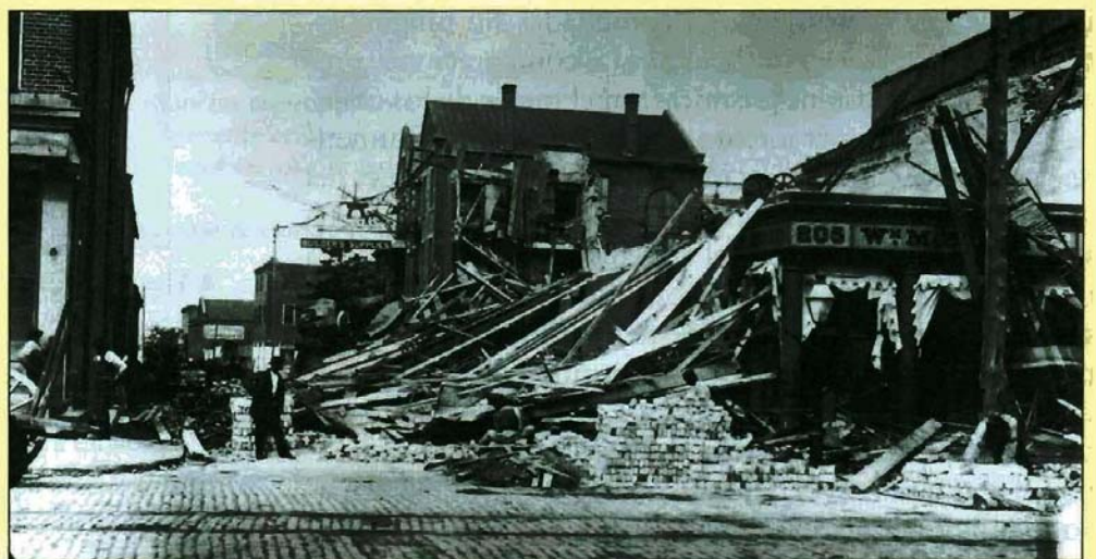
▲ Figura 11.A Daños en Charleston, Carolina del sur, causados por el terremoto que tuvo lugar el 31 de agosto de 1886. El daño osciló entre la caída de chimeneas y la ruptura de paredes hasta el hundimiento total. (Foto cortesía de U. S. Geological Survey.)
