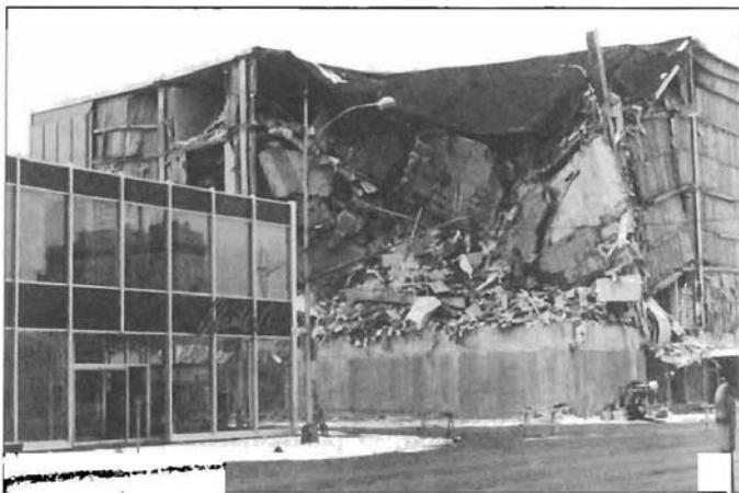
▲ Figura 11.16 Daños causados al edificio de cinco plantas J. C. Penney Co., Anchorage, Alaska. El edificio adyacente sufrió muy pocos daños estructurales. (Foto cortesía de NOAA/Seattle.)
