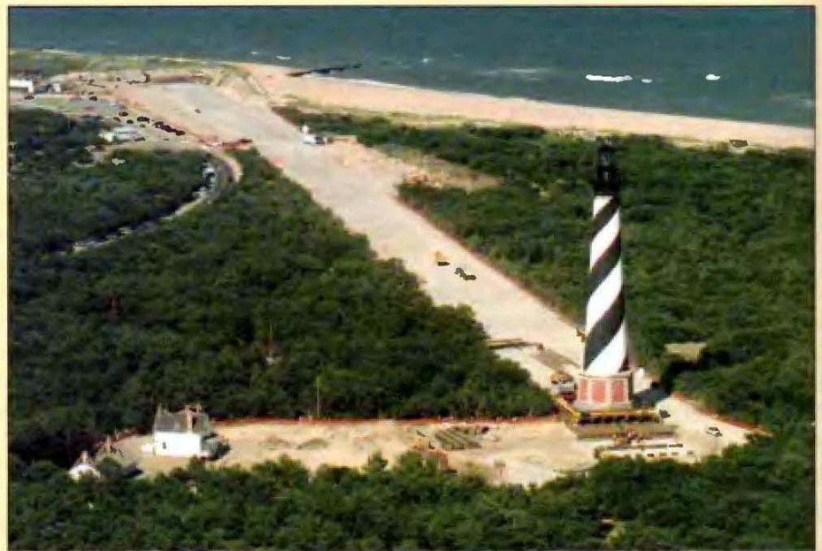
▲ Figura 20.C Cuando el faro del cabo Hatteras de Carolina del Norte fue amenazado por la erosión de la línea de costa en 1999, fue trasladado a 488 metros de la línea de costa. (Foto de Drew Wilson © 1999, Virginian-Pilot .)
