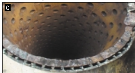
Enrejado después del tratamiento con JetBLASTER
