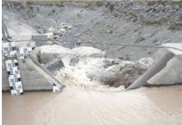
Foto 6.2. Vertedero trapezoidal y regleta. Estación “Los Crespos”
