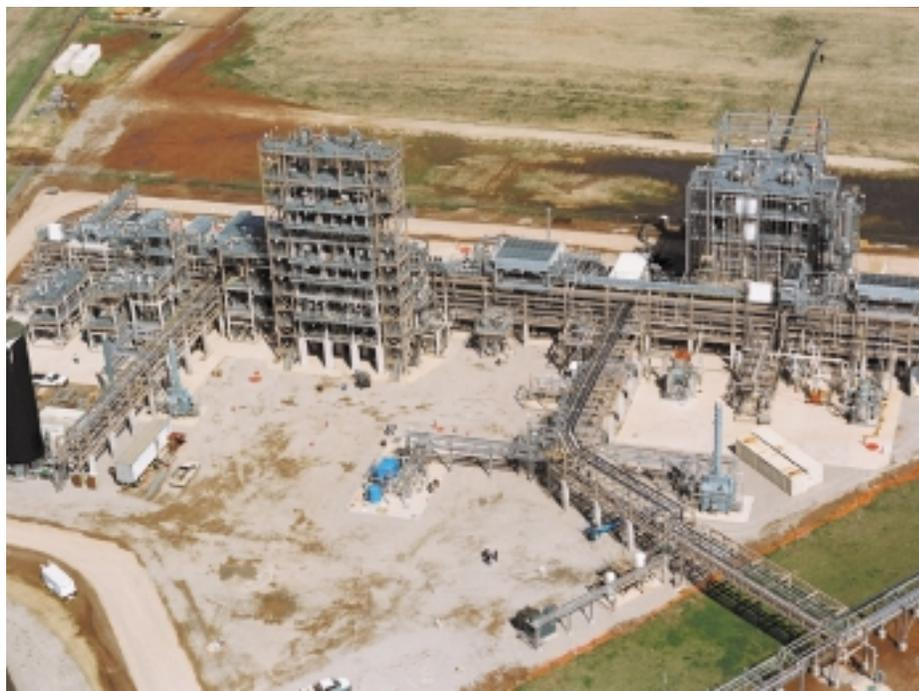
^ La planta de demostración de GTL de la compañía ConocoPhillips, en Ponca City, Oklahoma, EUA. Esta planta fue terminada en marzo de 2003 y está diseñada para convertir 114,600 m<sup>3</sup> [4 MMpc] por día de gas natural en 64 m<sup>3</sup>/d [400 B/D] de diesel y nafta libres de azufre. (Los derechos de autor de la fotografía pertenecen a ConocoPhillips).
