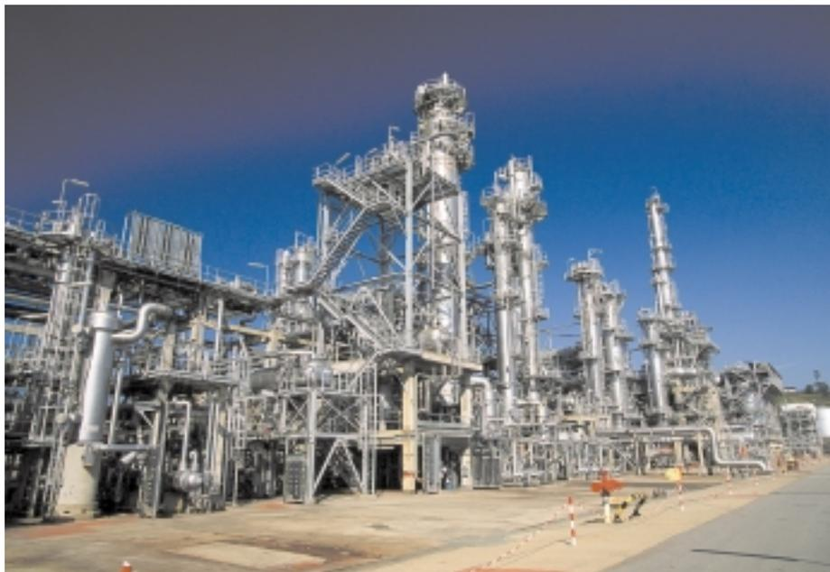
^ Planta de GTL de Shell en Bintulu, Malasia, en operación desde 1993. Utilizando un proceso patentado de Shell, la planta de Bintulu convierte gas natural enviado por gasoducto desde Sarawak en 1990 m<sup>3</sup>/d [12,500 B/D] de diesel, kerosén y nafta limpios. (Fotografía provista por gentileza de Shell Chemicals Singapur).
