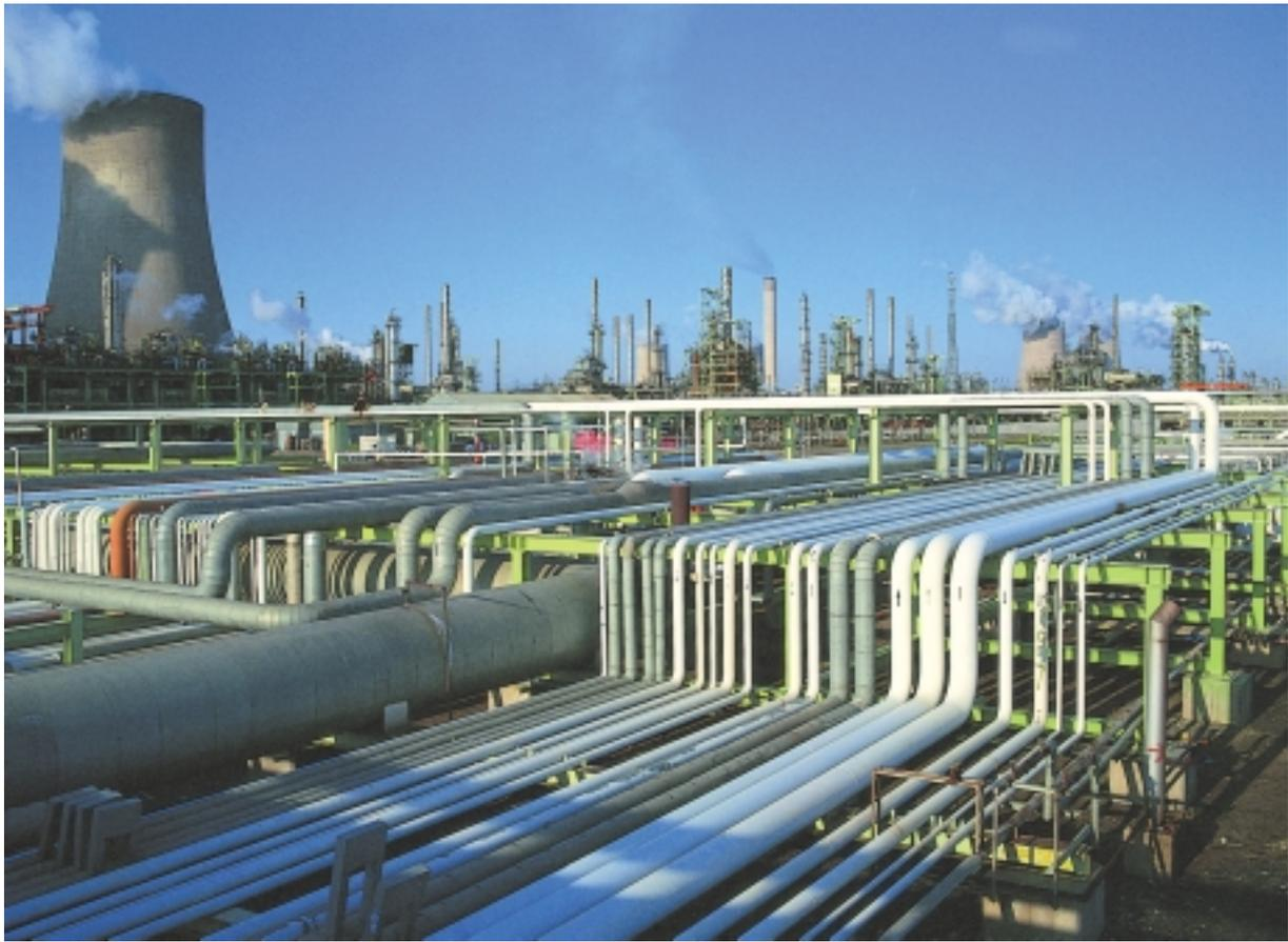
^ Sasol Synthetic Fuels, Secunda, Sudáfrica. Sasol opera dos de esas plantas, aplicando tecnología de conversión de gas a líquidos (GTL) para convertir el gas natural derivado del carbón en combustibles líquidos. (Los derechos de autor de la fotografía pertenecen a Sasol Limited).
